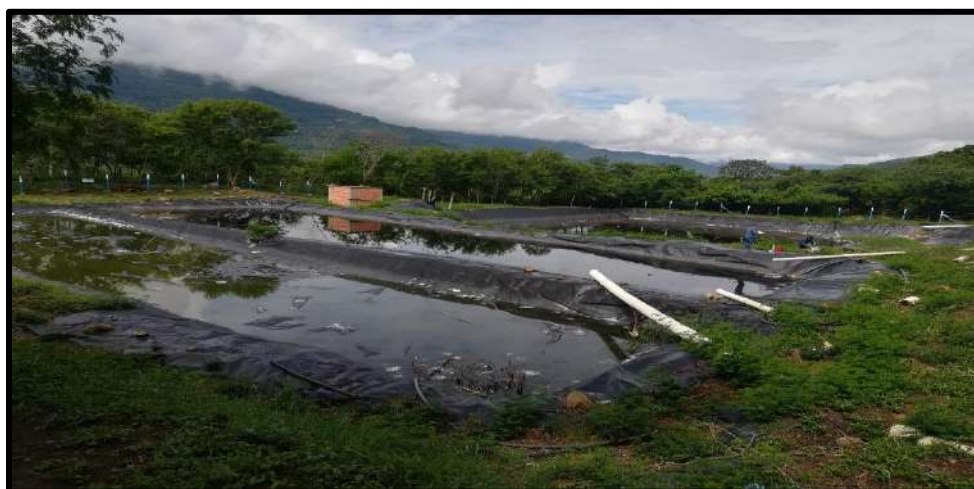
Fotografía 45. Piscina de lixiviados relleno sanitario EL CUCHARO
